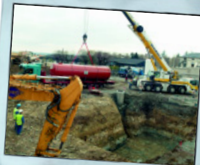
INSTALLATION DE 2 NOUVELLES CUVES À FIOUL EN AVRIL
